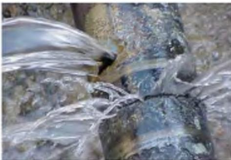
**Рис. 4.30. Потери воды на магистральном водопроводе**
